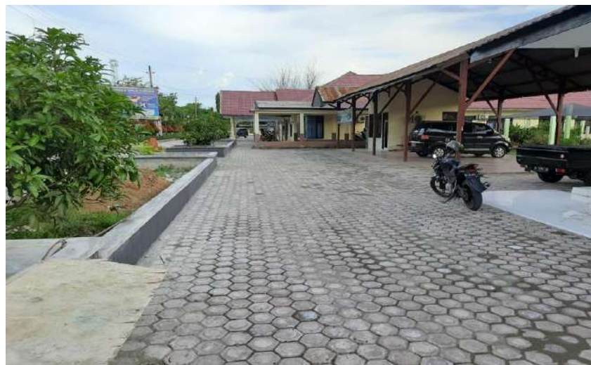
PEMASANGAN PAVING BLOK DAN TAMAN DINAS
